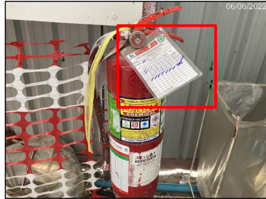
ภาพที่ 49 ตรวจสอบถังดับเพลิง
