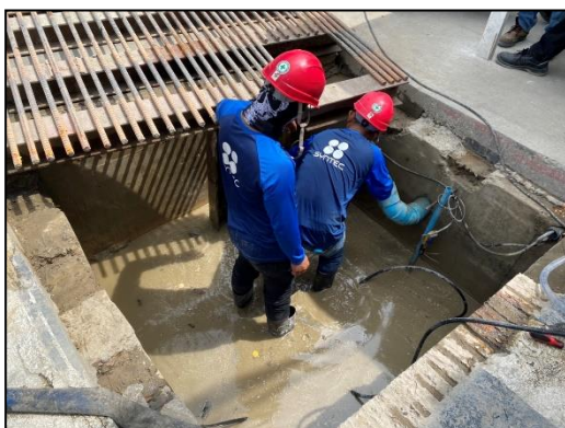
ภาพที่ 65 ขุดลอกท่อระบายน้ำ
