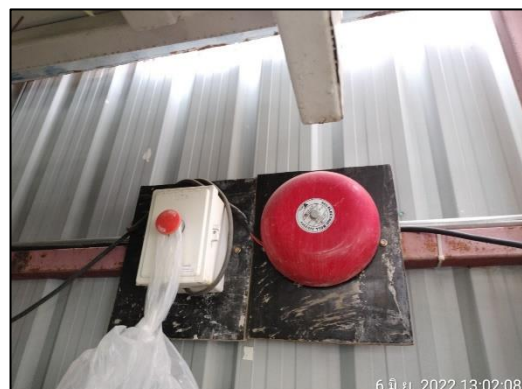
ภาพที่ 36 อุปกรณ์แจ้งเตือนเพลิงไหม้
